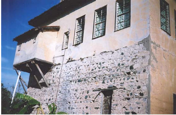
Fotoğraf 10: Payandalar ile desteklenmiş, dışa çıkıntı şeklinde tuvalet ve banyo, s.220.
