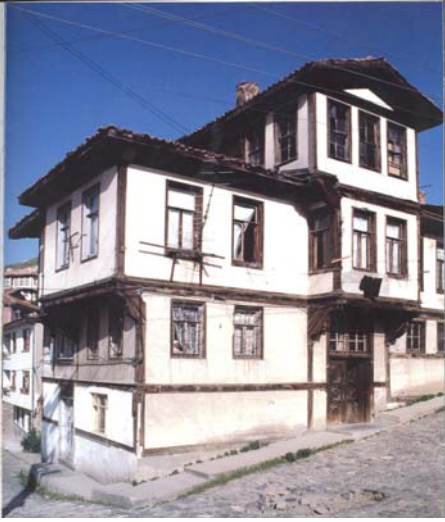
Fotoğraf 2: Çıkma düzeniyle mimari üslubun belirginleştiği Kastamonu evi, s.170.
